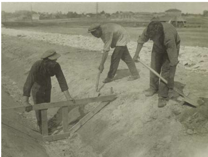
Разбивка профиля кювета по изготовленному шаблону, 1939 г.
