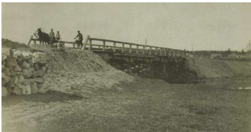
Егорьевский РДО ведет строительство подходов к деревянному мосту на областной дороге. 1933 г.
