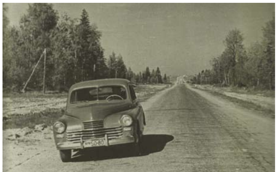
Вновь построенная дорога областного значения «Шаховская – Середа». Обслуживает Шаховское ЛУАД.
