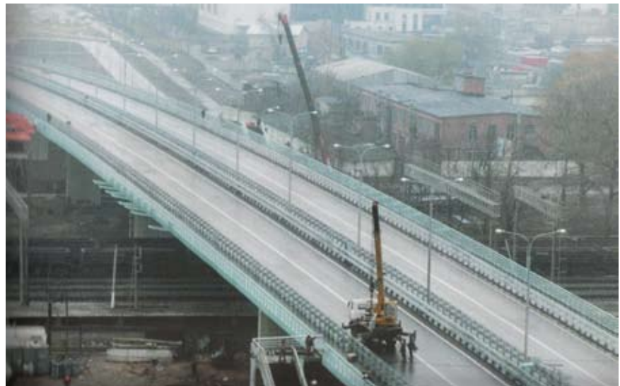
Строительство путепровода в г. Люберцы. 2005 год.
