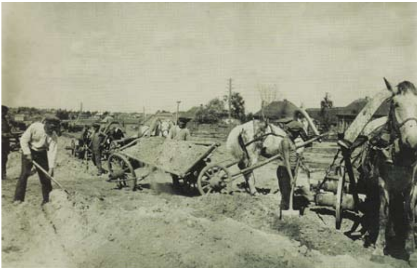
Строительство первых километров булыжных мостовых в Ногинском районе. Работы ведет Ногинский РДО. 1932 г.
