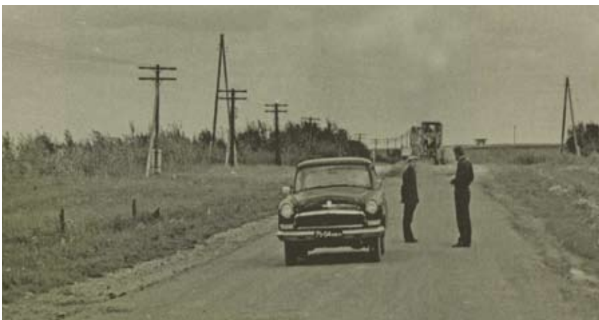
Подъезды к Дровнино, построенной методом смешения щебня с дегтем. Дорогу строит Уваровское ЛУАД. 1972 – 1974 гг.
