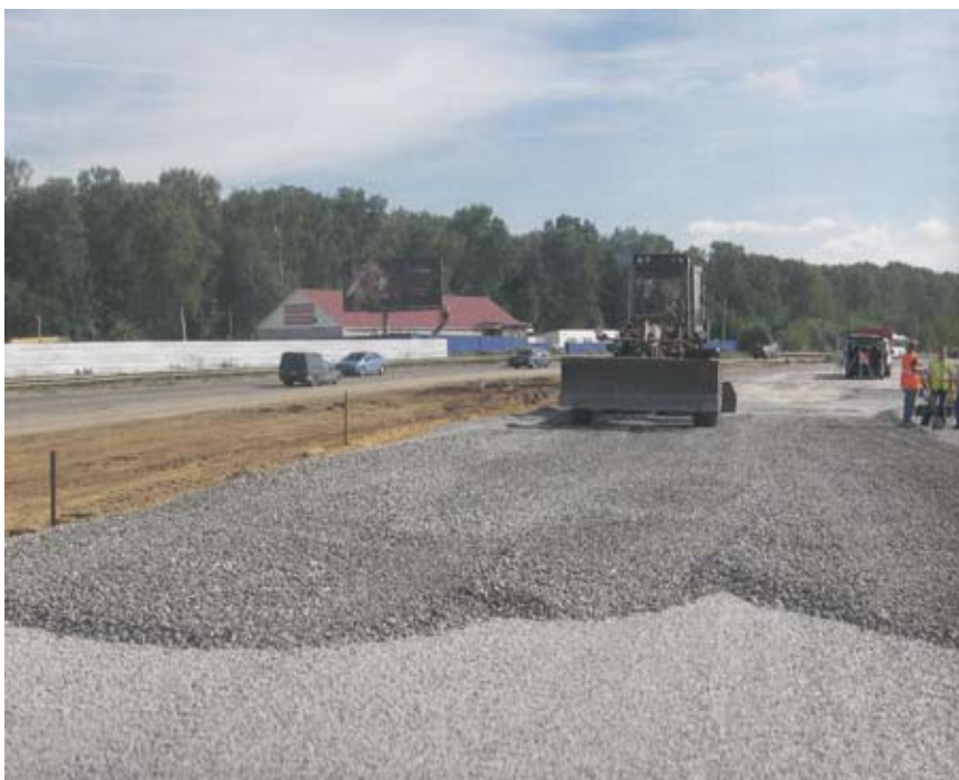
Устройство щебеночного основания на дорогах
