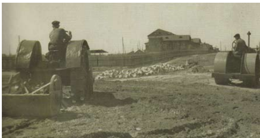
Строительство ул. Советская в п. Луховицы, 1939 г. Первый приобретенный трактор ХТЗ с волокушей и первый мотокаток.
